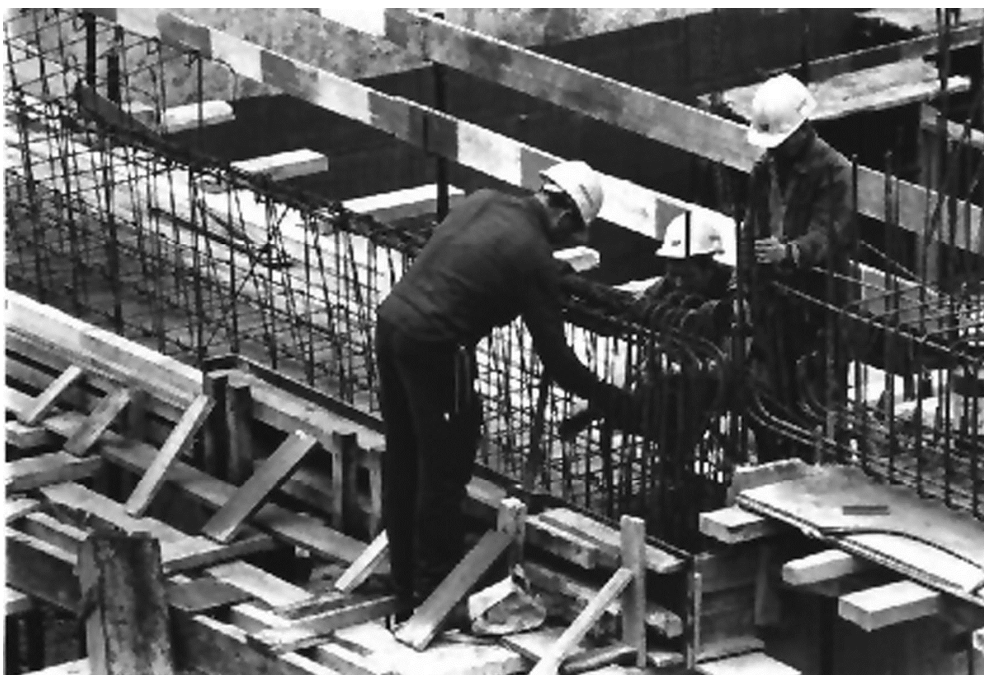
Encofradores. Foto: Lluís Salom (Archivo Histórico de CC.OO) Fundación 1º de Mayo
